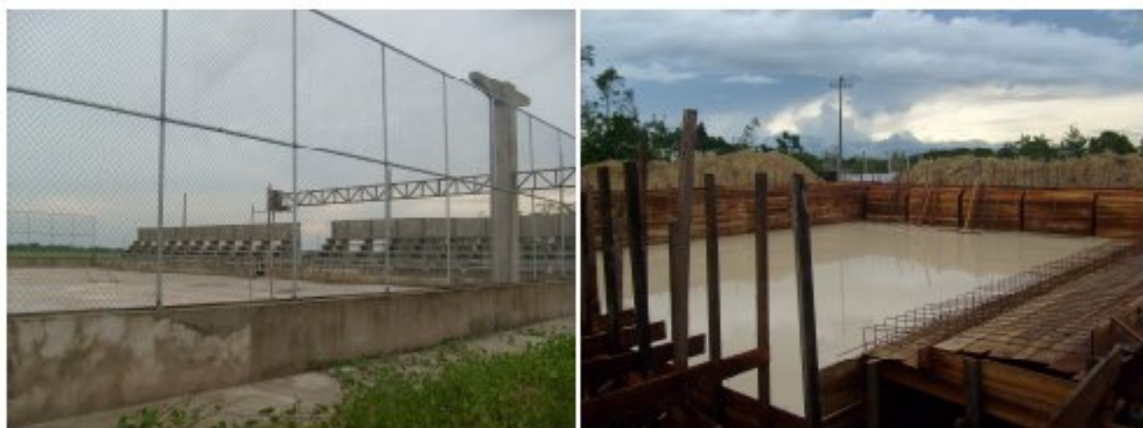
Obras da Quadra Polivalente e Piscina Semi-Olímpica – Campus de Castanhal
